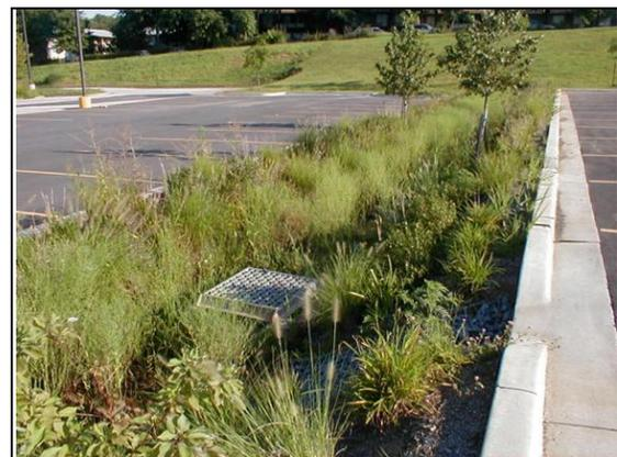
Figure 5-6. Biofiltration Planter
